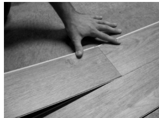
Figura 5. Incline el extremo de la tabla siguiente.
