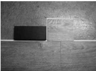
Fig. 7 – Donnez un coup au côté de la planche avec bloc de frappe.
