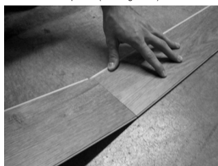
Fig. 3 – Orientez la languette d'extrémité dans la rainure d'extrémité sur les planches de la rangée initiale.
