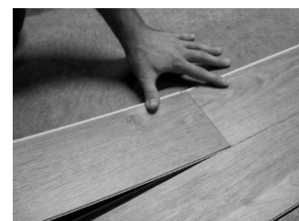
Fig. 5 – Orientez l'extrémité de la planche suivante.
