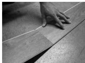
Fig. 3 – Orientez la languette d'extrémité dans la rainure d'extrémité sur les planches de la rangée initiale.
