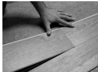
Figura 5. Incline el extremo de la tabla siguiente.
