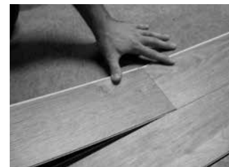
Fig. 5 – Orientez l'extrémité de la planche suivante.
