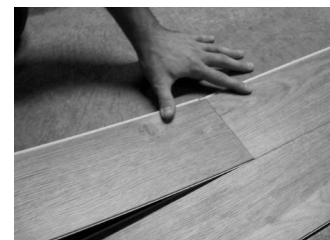
Fig. 5 – Orientez l'extrémité de la planche suivante.
