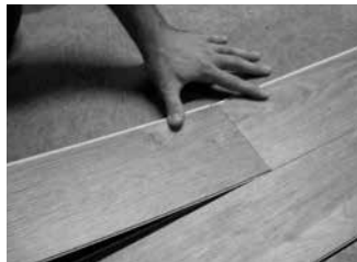
Figura 5. Incline el extremo de la tabla siguiente.
