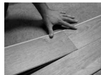
Fig. 5 – Orientez l'extrémité de la planche suivante.
