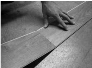
Figura 3. Incline la lengüeta terminal en el extremo de la ranura de las tablas de la hilera inicial.
