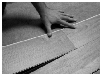
Figura 5. Incline el extremo de la tabla siguiente.
