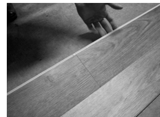
Fig. 6 – Verrouillez le long côté lorsque les extrémités sont déjà verrouillées.
