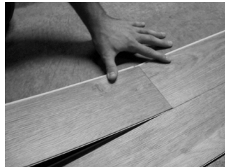
Fig. 5 – Orientez l'extrémité de la planche suivante.
