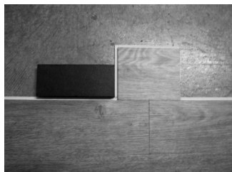
Figura 7. Golpee ligeramente el lado de la tabla con un taco de impacto.
