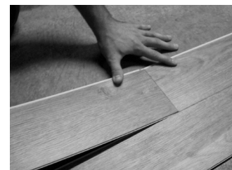
Fig. 5 – Orientez l'extrémité de la planche suivante.
