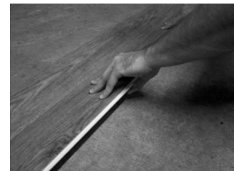
Fig. 4 – Orientez le côté long dans la rangée précédente.
