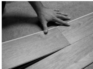
Figura 5. Incline el extremo de la tabla siguiente.
