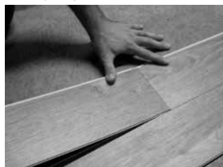
Figura 5. Incline el extremo de la tabla siguiente.
