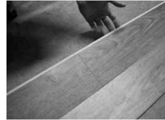
Figura 6. Enganche del lado largo con los extremos previamente enganchados.
