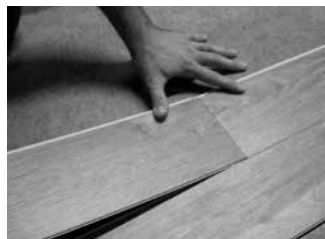
Fig. 5 – Orientez l'extrémité de la planche suivante.
