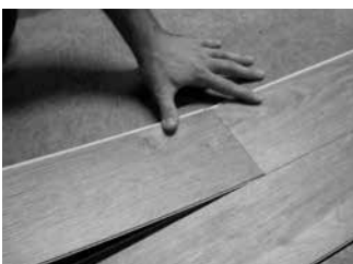
Fig. 5 - Incliner l'extrémité de la planche suivante
