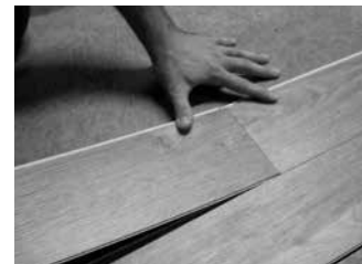
Fig. 5 – Incline el extremo de la siguiente tabla
