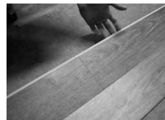
Fig. 6 – Enganche el lado largo con los extremos ya enganchados
